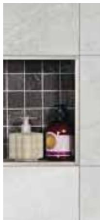
**ABLAGENISCHE** in der Dusche oder über Badewanne für Utensilien. Nische in der Trockenbauwand, gefliest, Fliesenkanten mit Kanten-schutzprofil und inkl. Abdichtungsarbeiten. Lage und Abmessungen werden je nach Einbausituation durch den Architekten vor Ort festgelegt.
